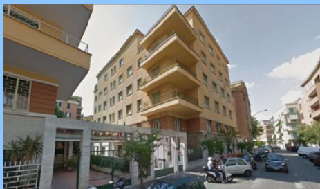
SEDE VIA G DA PROCIDA
